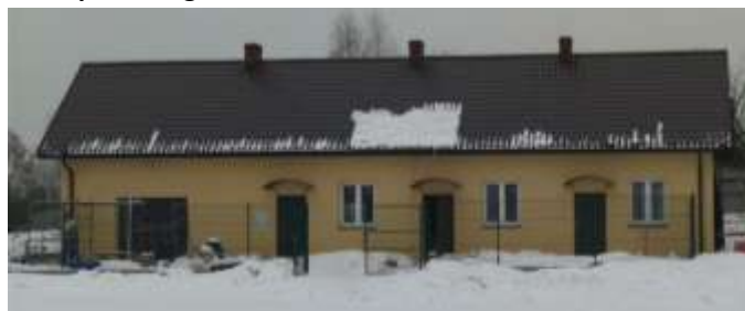
Zdjęcie 15 Budynek zaplecza sportowego
