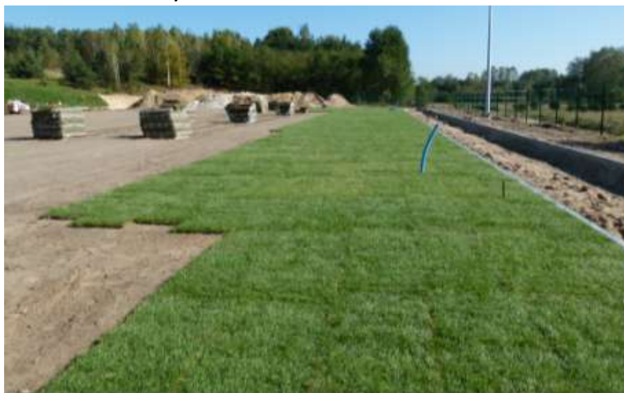
Zdjęcie 14 Stadion w trakcie budowy
