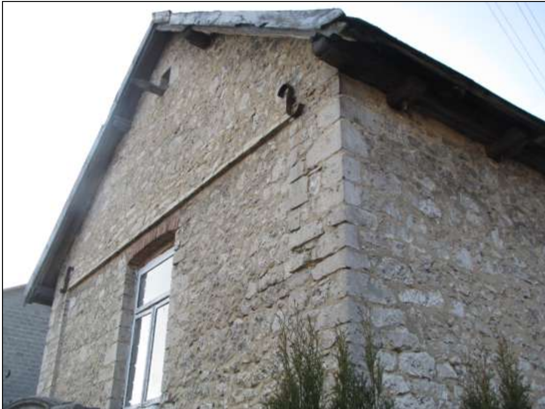
Zdjęcie 4 Budynek mieszkalny z 1942 roku wybudowany z wykorzystaniem kamienia wapiennego
