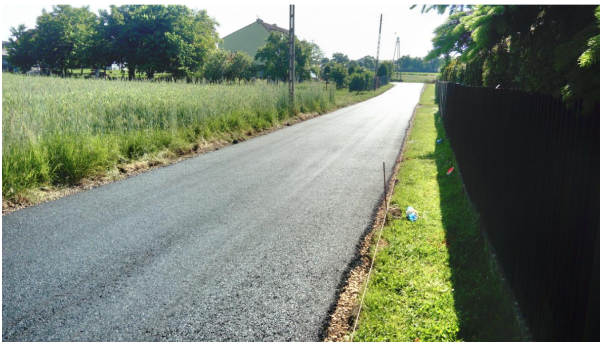
Zdjęcie 16 Gołuchowice – droga w trakcie przebudowy
