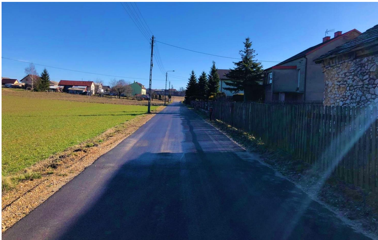
Zdjęcie 17 Gołuchowice- droga po przebudowie
