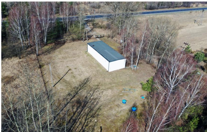
Zdjęcie 66 Ujęcie wody w Lgocie Murowanej
