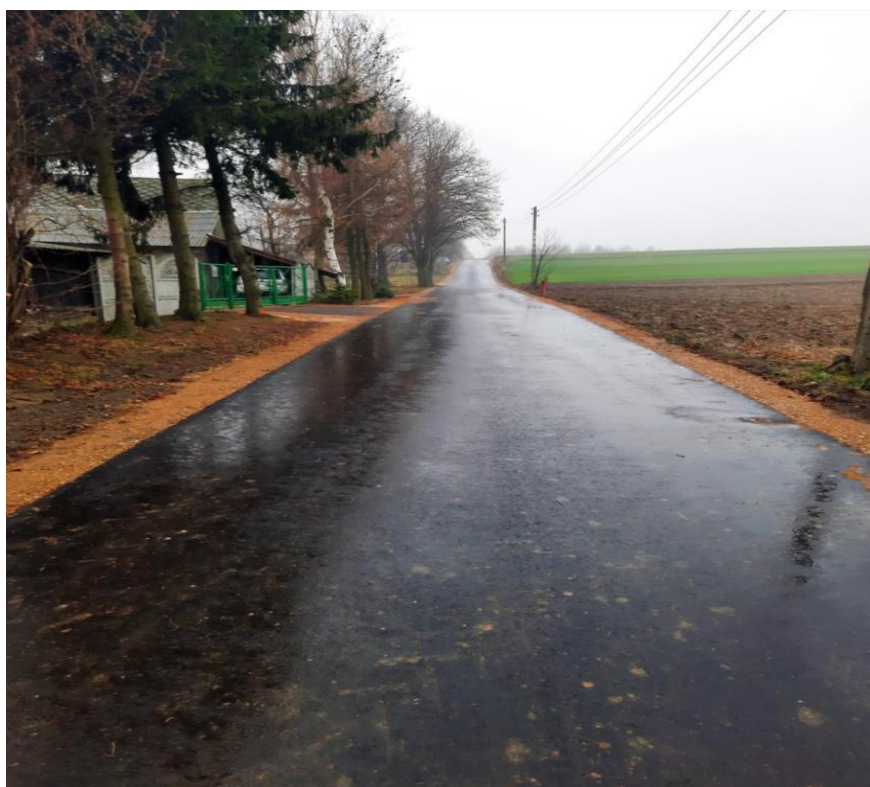
Zdjęcie 24 Droga w miejscowości Dobrogoszczyce – stan po przebudowie
