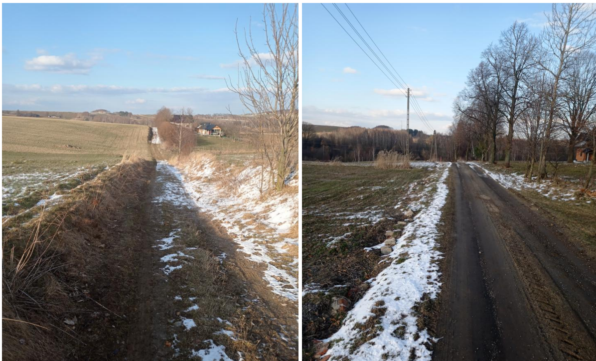
Zdjęcie 23 Droga w miejscowości Dobrogoszczyce – stan przed przebudową
