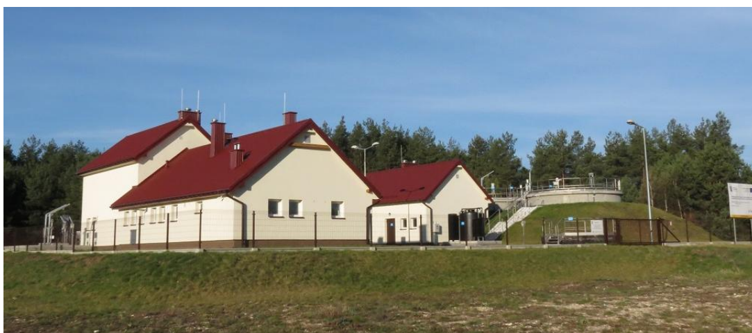
Zdjęcie 42 Oczyszczalnia ścieków w Kostkowicach
