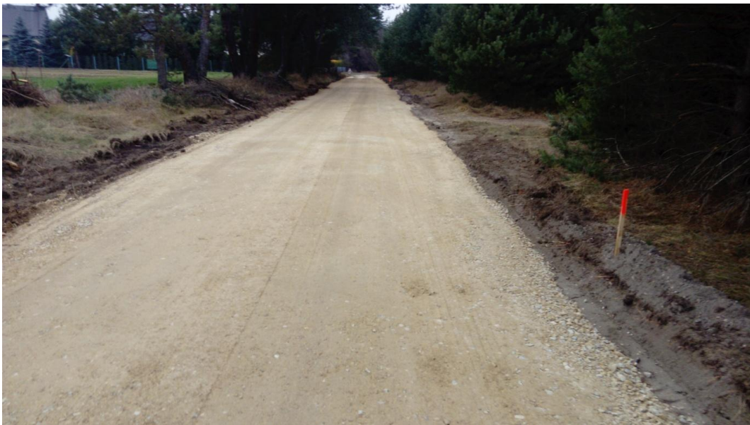
Zdjęcie 22 Lgotka – droga w trakcie przebudowy
