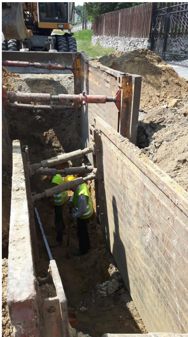
Zdjęcie 14 Budowa kanalizacji sanitarnej w m. Kostkowice, prace w toku
