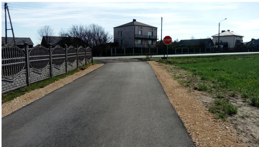
Zdjęcie 23 Lgotka – droga po przebudowie
