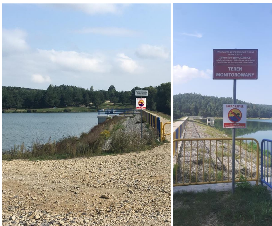
Rysunek 8. Oznakowanie zapory na zbiorniku retencyjnym Dzibice I. Źródło: Materiał własny
