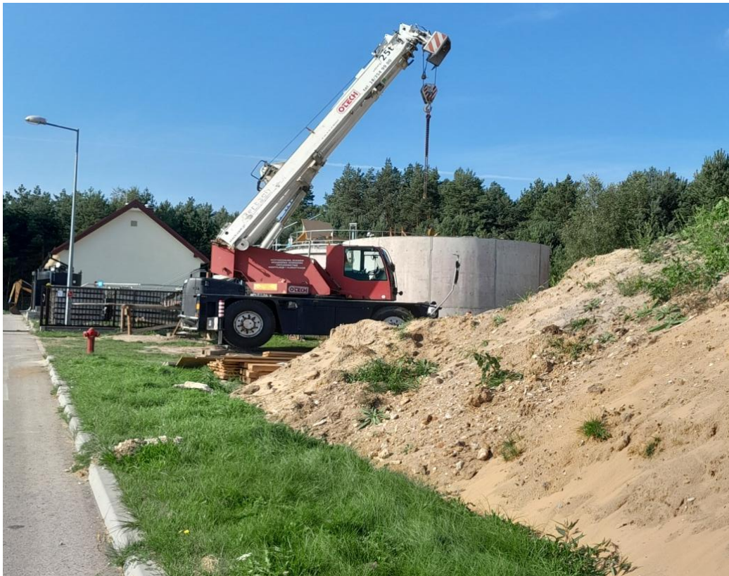
Zdjęcie 26 Oczyszczalnia ścieków w Kostkowicach w trakcie rozbudowy
