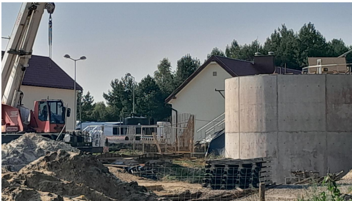
Zdjęcie 25 Oczyszczalnia ścieków w Kostkowicach w trakcie rozbudowy
