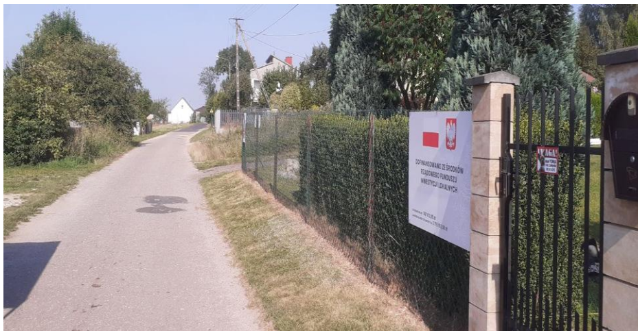
Zdjęcie 34 Droga w Białej – Błotnej przed przebudową
