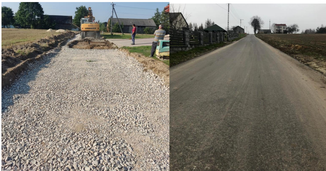
Zdjęcie 36 Droga w Białej – Błotnej w trakcie przebudowy
