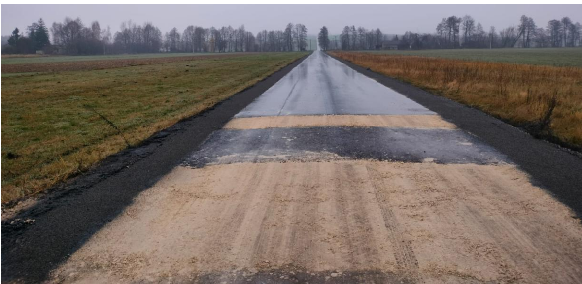
Zdjęcie 23 Droga w miejscowości Browarek – w trakcie przebudowy
