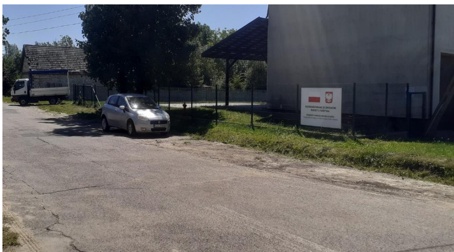
Zdjęcie 35 Droga w Białej – Błotnej przed przebudową
