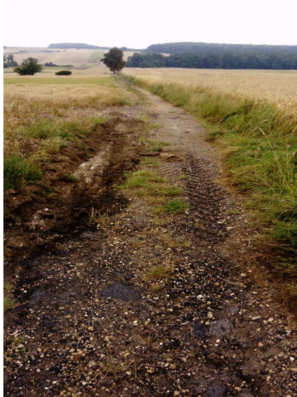
Zdjęcie 20 Droga w Siedliszowicach – stan przed realizacją zadania
