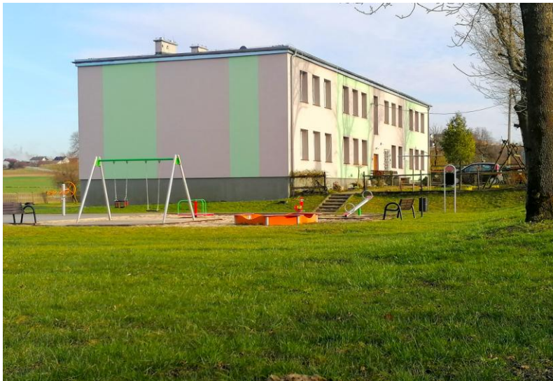
Zdjęcie 82 Budynek mieszkań socjalnych w Siedliszowicach
