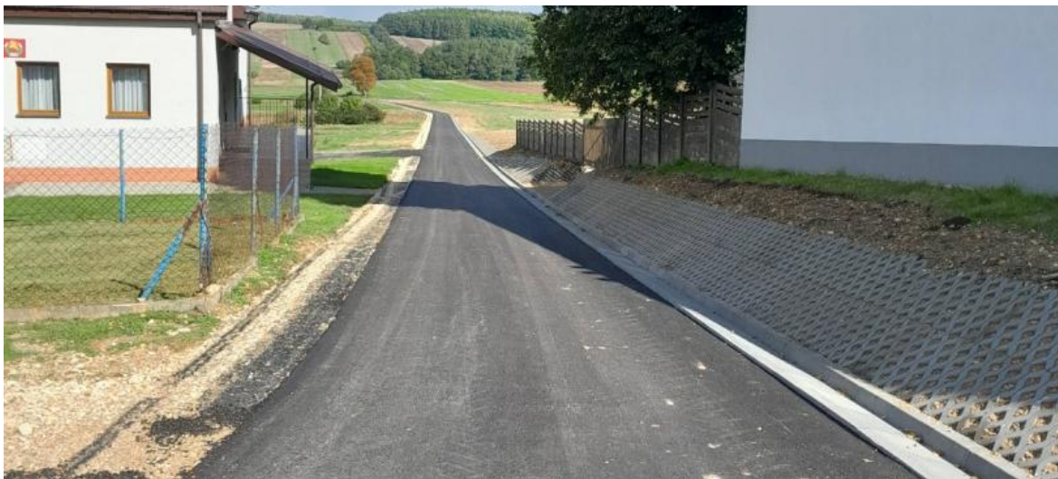
Zdjęcie 22 Droga w Siedliszowicach stan po przebudowie
