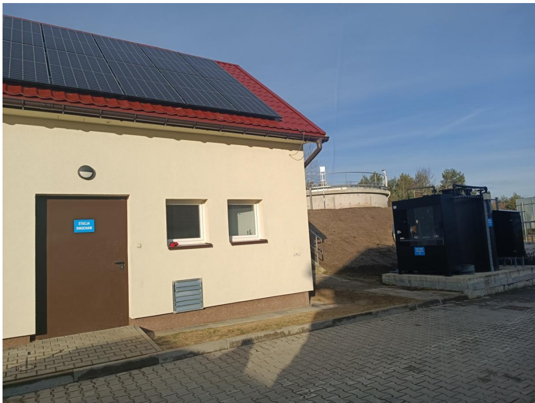
Zdjęcie 27 Oczyszczalnia ścieków w Kostkowicach po rozbudowie
